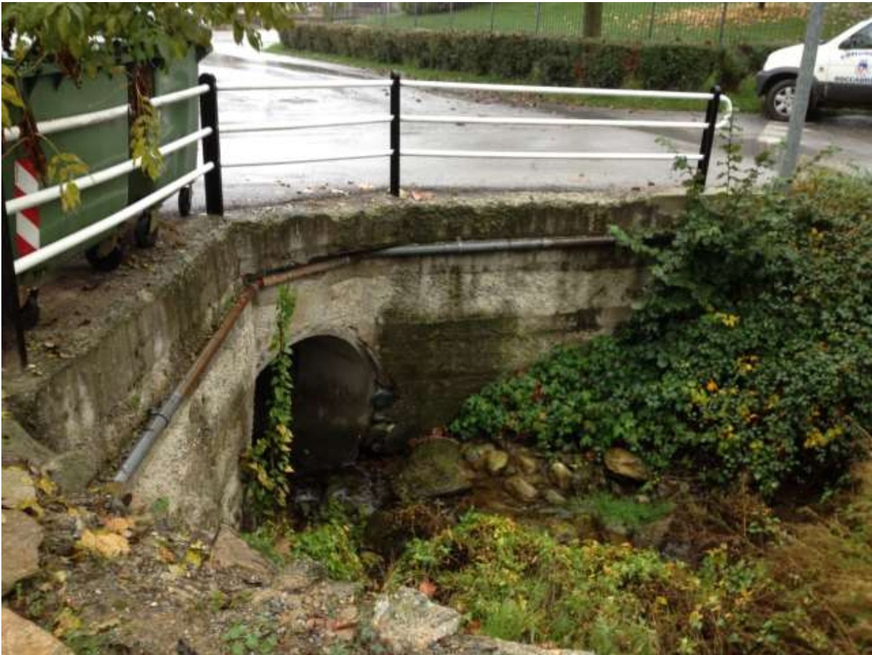
Foto 3 – attraversamento del Rio Garino in corrispondenza della Strada Comunale Occitane
